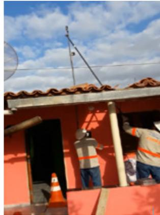
Criação de uma ferramenta própria (vara de PVC) para colocação e retirada da alça do ramal de ligação diretamente do solo, permitindo o cumprimento das metas propostas e, ao mesmo tempo, evitando o risco de queda do colaborador.
