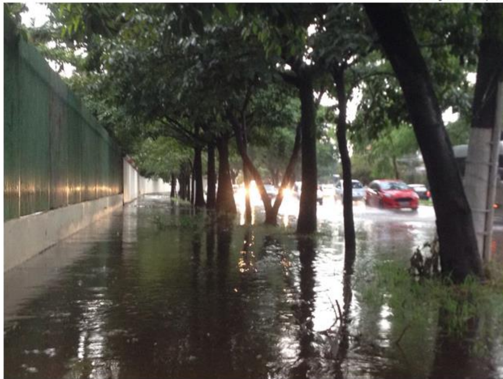
Avenida Lineu de Paula Machado parcialmente alagada; calçada do jockey tomada pela água
