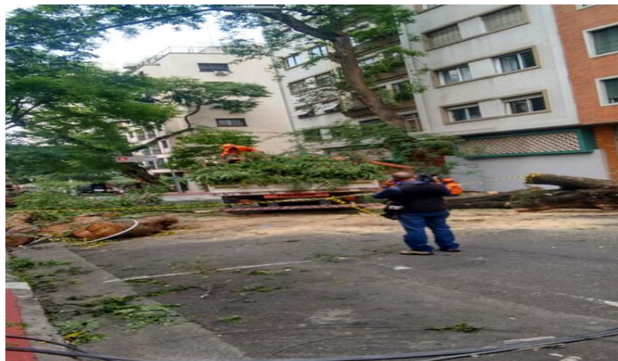
Queda de uma árvore de grande porte sobre a rede deixando fio de alta tensão partido na RUA: Haddock Lobo x Alameda Tietê - Circuito: HCL 105
