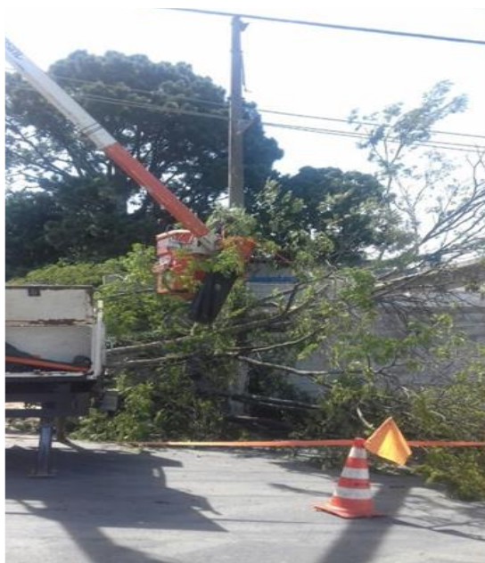
Queda de uma árvore de grande porte sobre a rede deixando fio de alta tensão partido na Rua José Magnani - Circuito: DIA 105.
