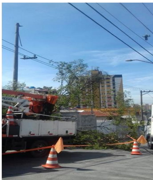
Queda de uma árvore de grande porte sobre a rede deixando fio de alta tensão partido na Rua José Magnani - Circuito: DIA 105.
