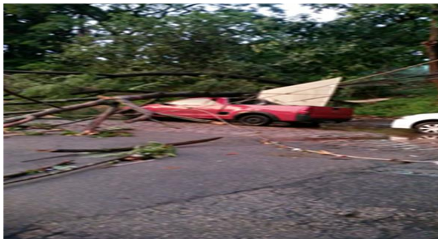
Queda de uma árvore de grande porte sobre a rede deixando fio de alta tensão partido na Rua: Rua Pantaleão Circuito: CAA 104 x PPU 115
