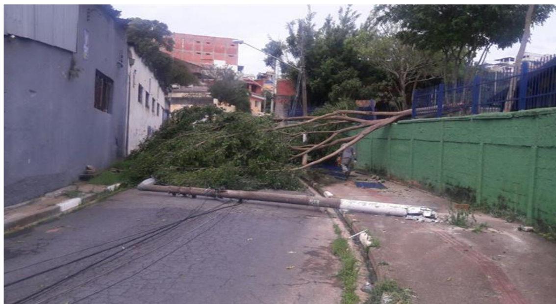
Queda de uma árvore de grande porte sobre a rede deixando fio de alta tensão partido na Rua: Paulo Sérgio Costabille Cebola - Circuito: AGU 0103.
