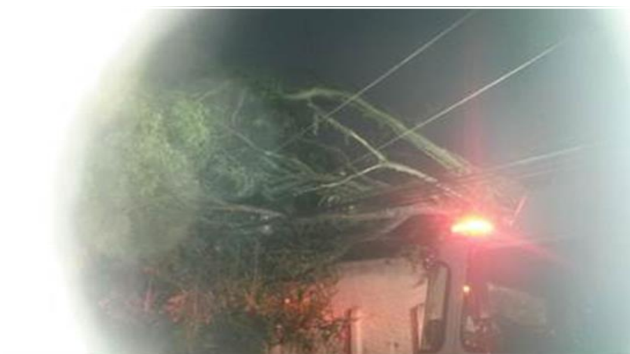
Queda de uma árvore de grande porte sobre a rede deixando fio de alta tensão partido na Rua Catulo da Paixão Cearense - Circuito: GUM 106
