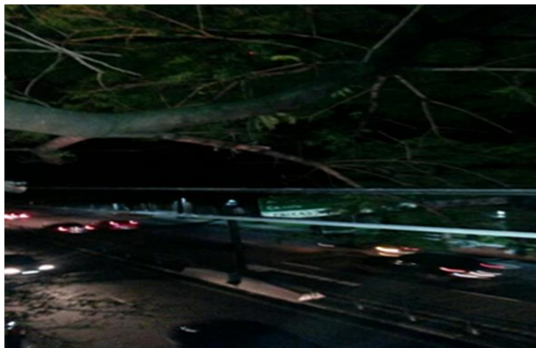
Queda de uma árvore de grande porte sobre a rede deixando fio de alta tensão partido na Av. Ibirapuera 820 Circuito: CLE 104
