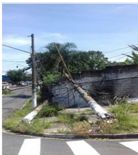
Queda de uma árvore de grande porte sobre a rede deixando fio de alta tensão partido na Avenida Dom Pedro I Circuito: DIA 114
