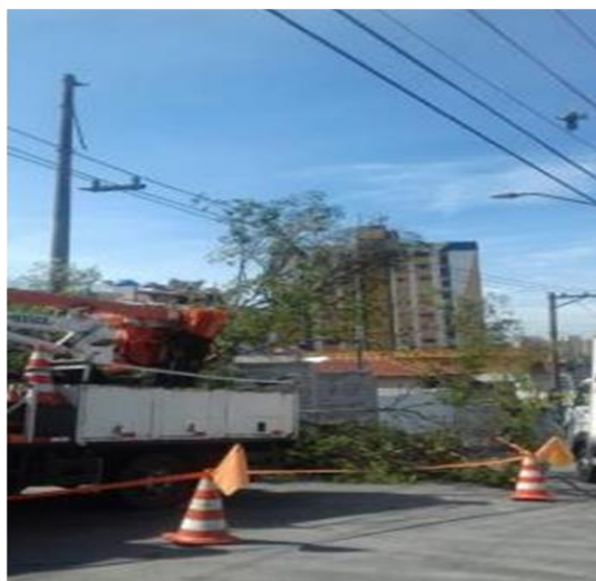
Queda de uma árvore de grande porte sobre a rede deixando fio de alta tensão partido na Rua José Magnani - Circuito: DIA 105.
