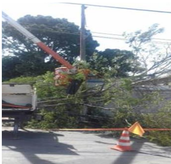
Queda de uma árvore de grande porte sobre a rede deixando fio de alta tensão partido na Rua José Magnani - Circuito: DIA 105.
