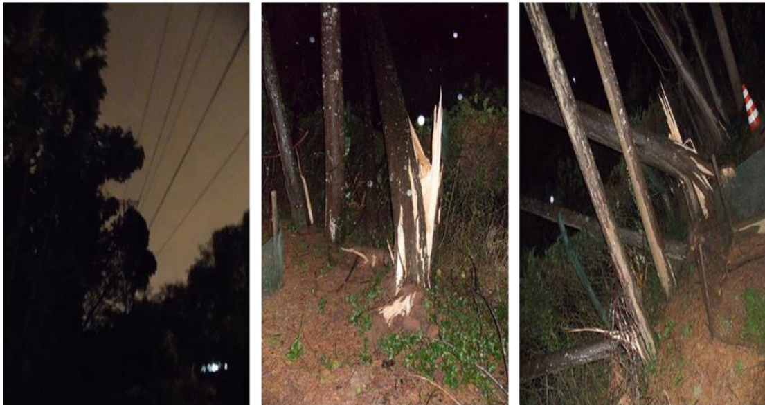
Queda de uma árvore de grande porte sobre a LTA Jandira – Cotia 1 e 2
