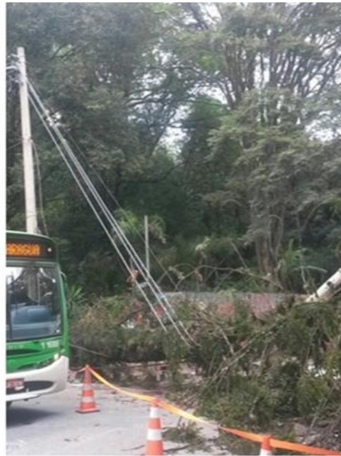
Queda de uma árvore de grande porte sobre a rede deixando fio de alta tensão partido na Rua Jerimanduba Circuito: GPR 102
