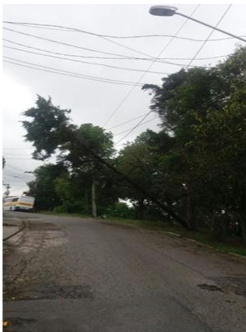
Queda de uma árvore de grande porte sobre a rede deixando fio de alta tensão partido na R Canto do Mangue Circuito: REM 111
