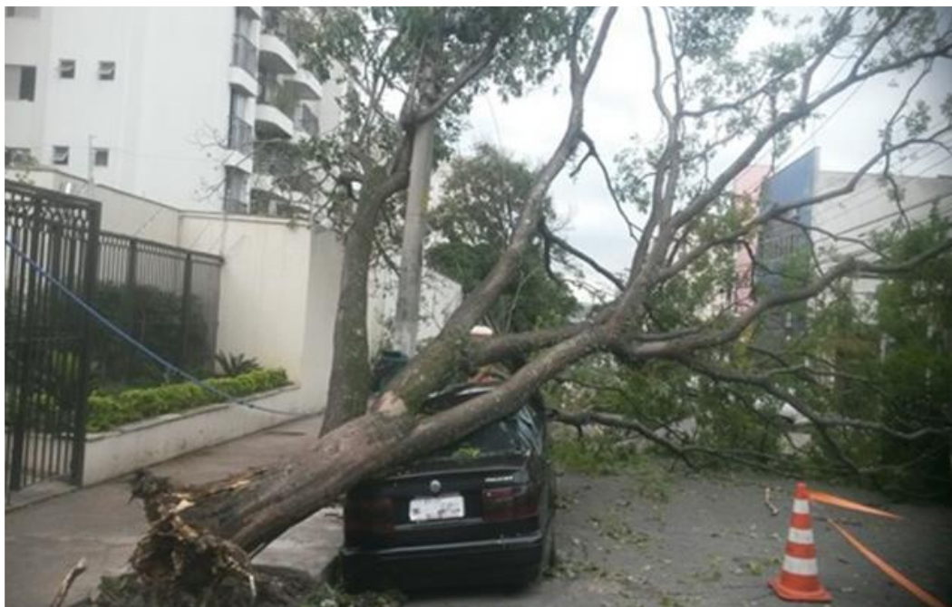
Queda de uma árvore de grande porte sobre a rede deixando fio de alta tensão partido na Rua Butantã Circuito: BUT 111
