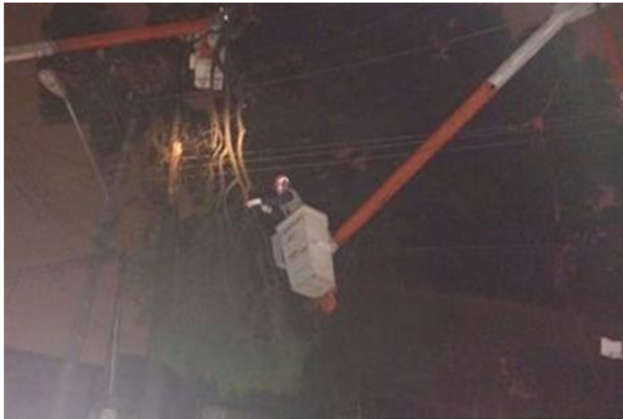
Queda de uma árvore de grande porte sobre a rede deixando fio de alta tensão partido na R Cachoeira Da Ilha Circuito: GNA 115
