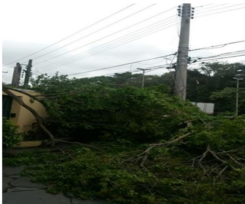
Queda de uma árvore de grande porte sobre a rede deixando fio de alta tensão partido na Rua Guaricanga Circuito: LEO 102
