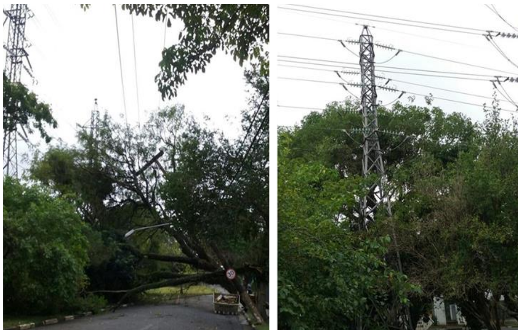
Queda de uma árvore de grande porte sobre a LTA Pirituba – Bandeirantes 1 e 2
