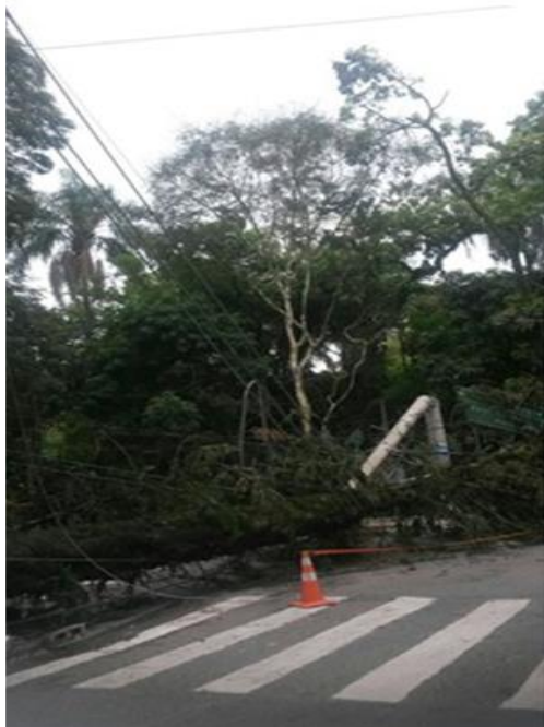
Queda de uma árvore de grande porte sobre a rede deixando fio de alta tensão partido na Rua Jerimanduba Circuito: GPR 102
