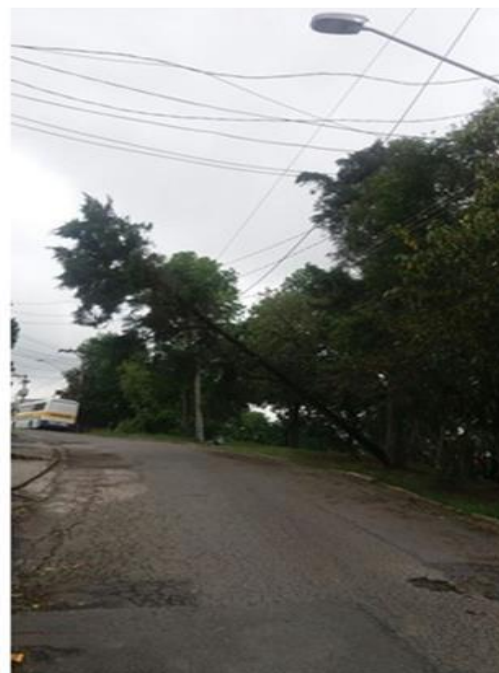
Queda de uma árvore de grande porte sobre a rede deixando fio de alta tensão partido na R Canto do Mangue Circuito: REM 111
