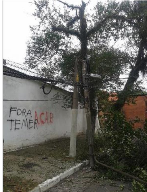
Queda de uma árvore de grande porte sobre a rede deixando fio de alta tensão Partido na R. Cardoso de Almeida e R. Mons Alberto Pequeno Circuito: BAL 0109
