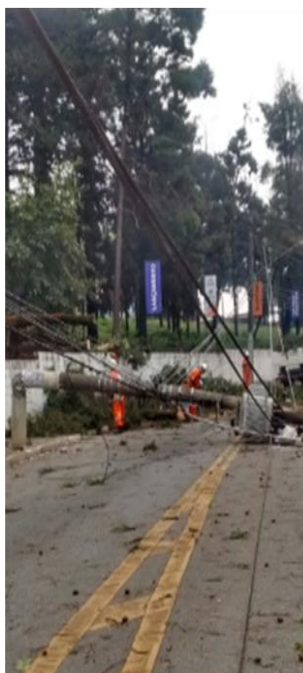
Queda de uma árvore de grande porte sobre a rede deixando fio de alta tensão Partido na Estrada Dom João Nery 3000 Circuito: BAR-0110
