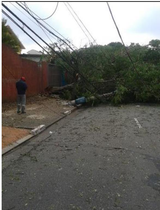
Queda de uma árvore de grande porte sobre a rede deixando fio de alta tensão Partido na R. Cardoso de Almeida e R. Mons Alberto Pequeno Circuito: BAL 0109
