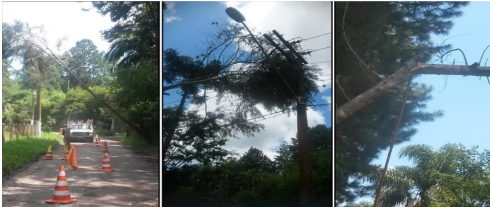
Queda de uma árvore de grande porte sobre a rede deixando fio de alta tensão partido na Estrada Sumaré S/N Parelheiros São Paulo
