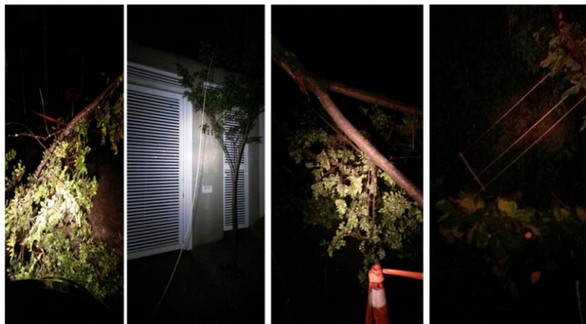
Queda de uma árvore de grande porte sobre a rede deixando fio de alta tensão partido na Rua Pistache Pq dos Príncipes - São Paulo.
