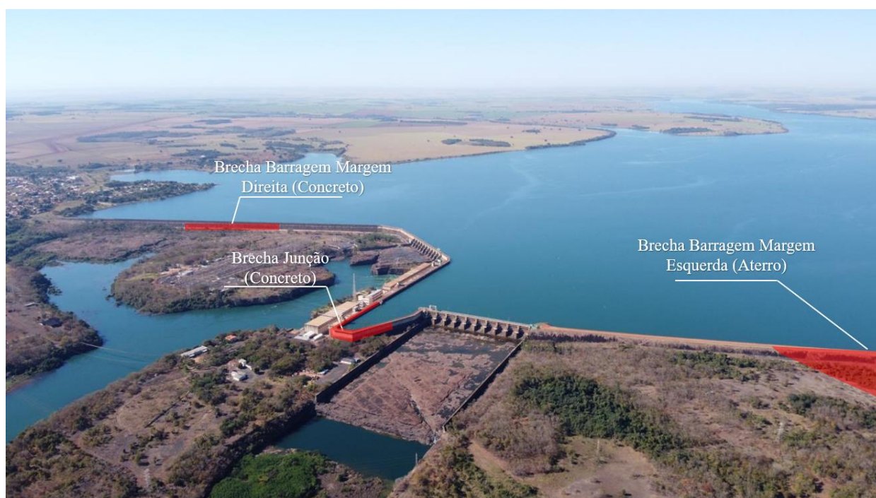
Figura 5 – Vista aérea posição das brechas de ruptura Segundo o Guia de Orientação e Formulários dos Planos de Ação de Emergência(ANA e
