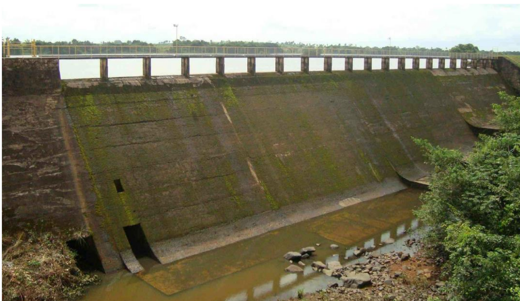
Figura 6 – Vertedouro da PCH Lajes – vista de jusante
