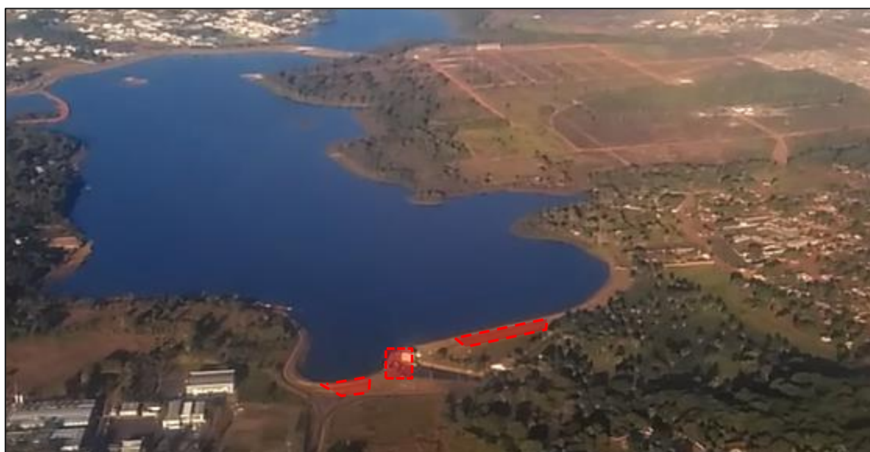
Figura 6 - Vista aérea da posição das brechas de ruptura
