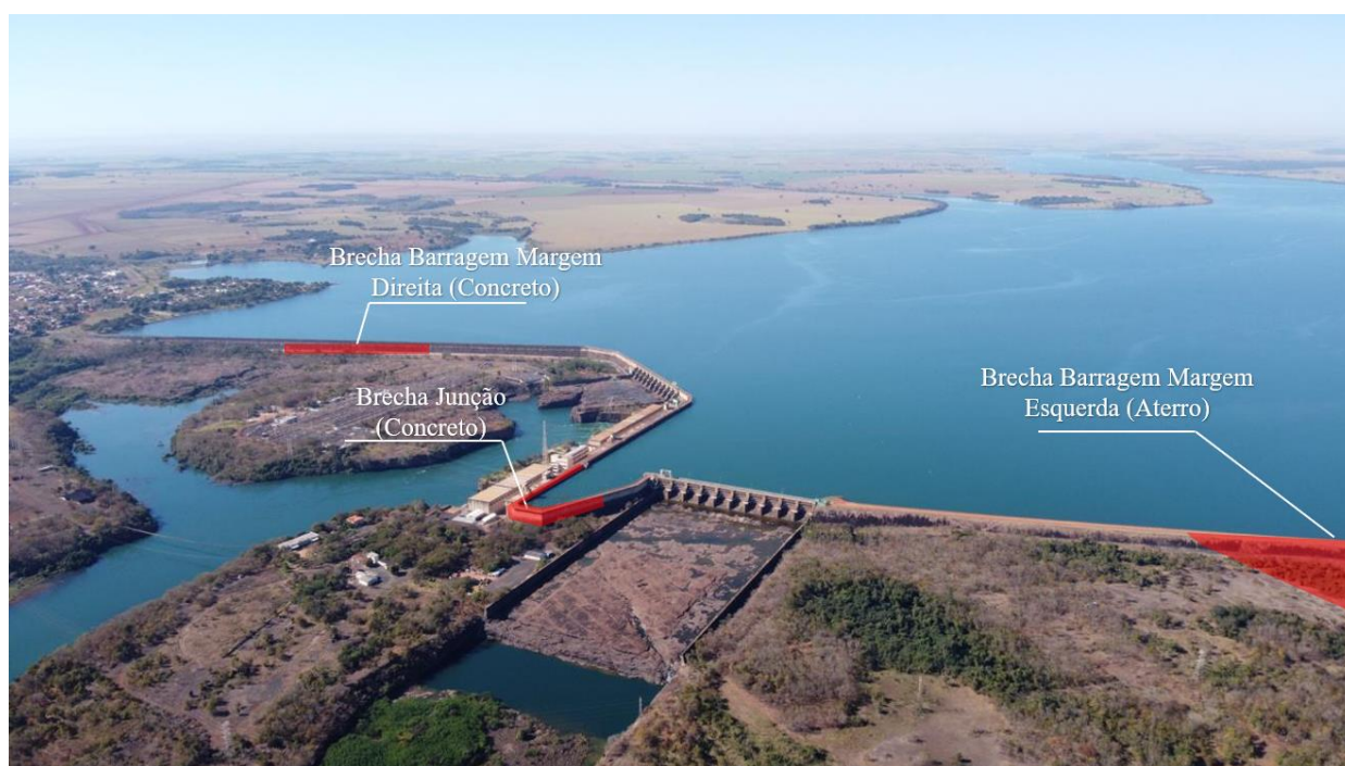
Figura 5 – Vista aérea posição das brechas de ruptura Segundo o Guia de Orientação e Formulários dos Planos de Ação de Emergência(ANA e
