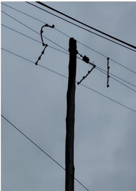
Necessário retirada de um poste de madeira de 11/400 com o topo quebrado
