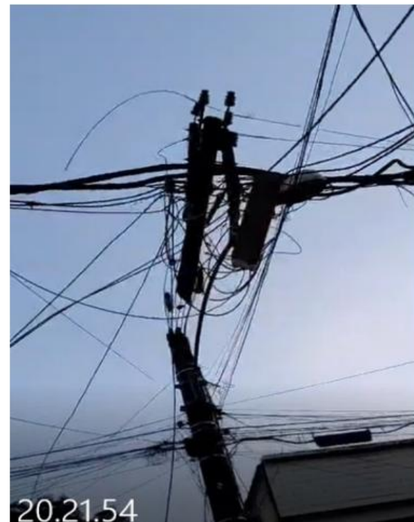
NECESSÁRIO SUBSTITUIÇÃO DE POSTE DE 11m, ESTRUTURA M2, SUSTENTA BT150 COM UMA CS NA CRUZETA
