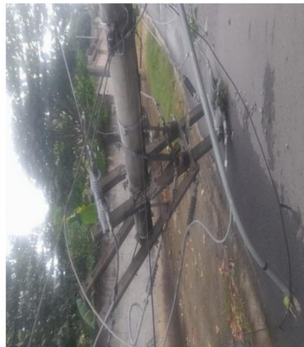
#NECESSÁRIO MK SUBSTITUIR POSTE 12.600 COM ESTRUTURA N3 N3CF .SG187375 WE CONDUTOR 185XLPE PARTIDO SENTIDO FONTE SG187375-6 PDR08.
