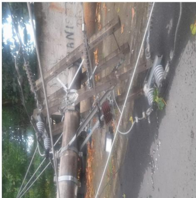
#NECESSÁRIO MK SUBSTITUIR POSTE 12.600 COM ESTRUTURA N3 N3CF .SG187375 WE CONDUTOR 185XLPE PARTIDO SENTIDO FONTE SG187375-6 PDR08.
