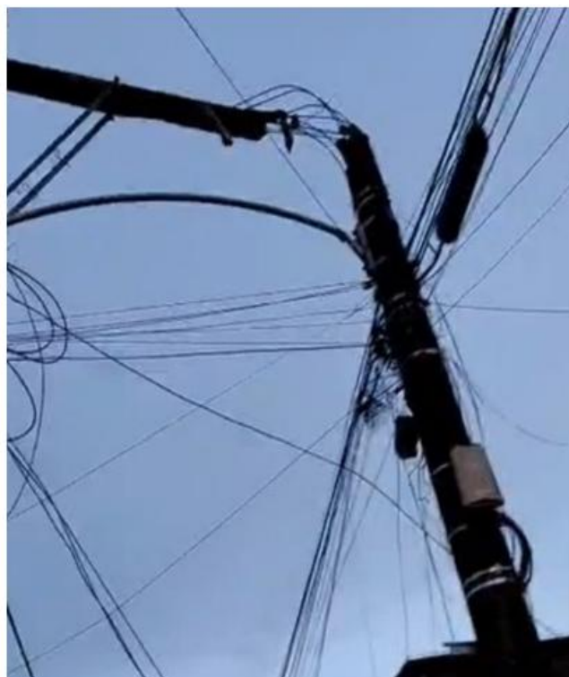
NECESSÁRIO SUBSTITUIÇÃO DE POSTE DE 11m, ESTRUTURA M2, SUSTENTA BT150 COM UMA CS NA CRUZETA
