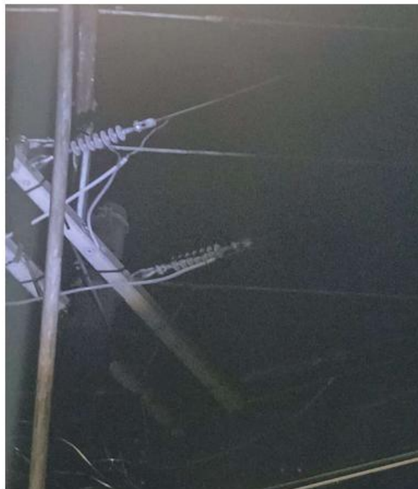
PARA -RAIOS E CHAVE FUSIVEL AVARIADAS
