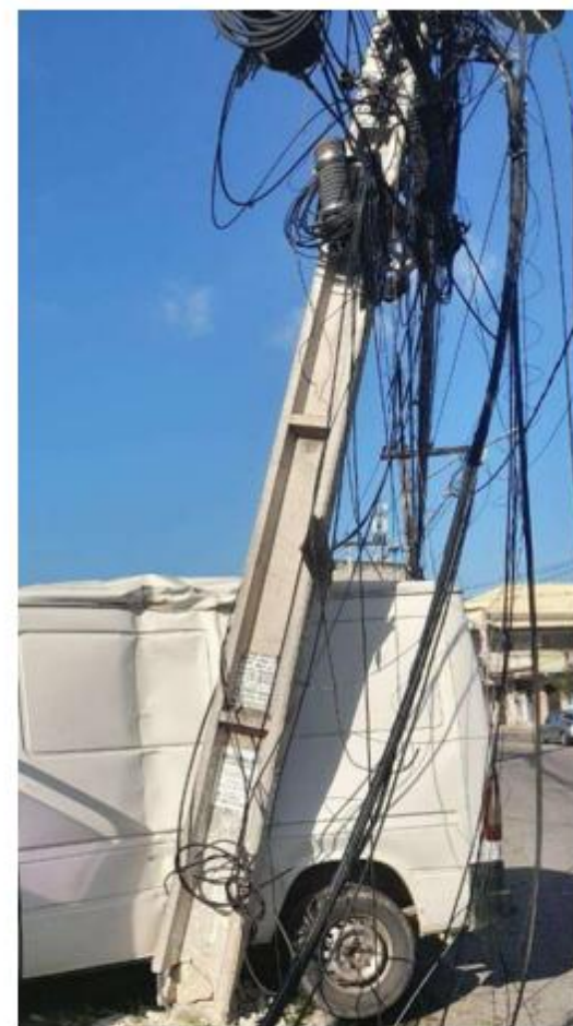
NECESSÁRIO SUBSTITUIR POSTE DE 11-400DT, COM ESTRUTURAS, 01-M2T, 01 N1CC - TRAFO DE 150kVA
