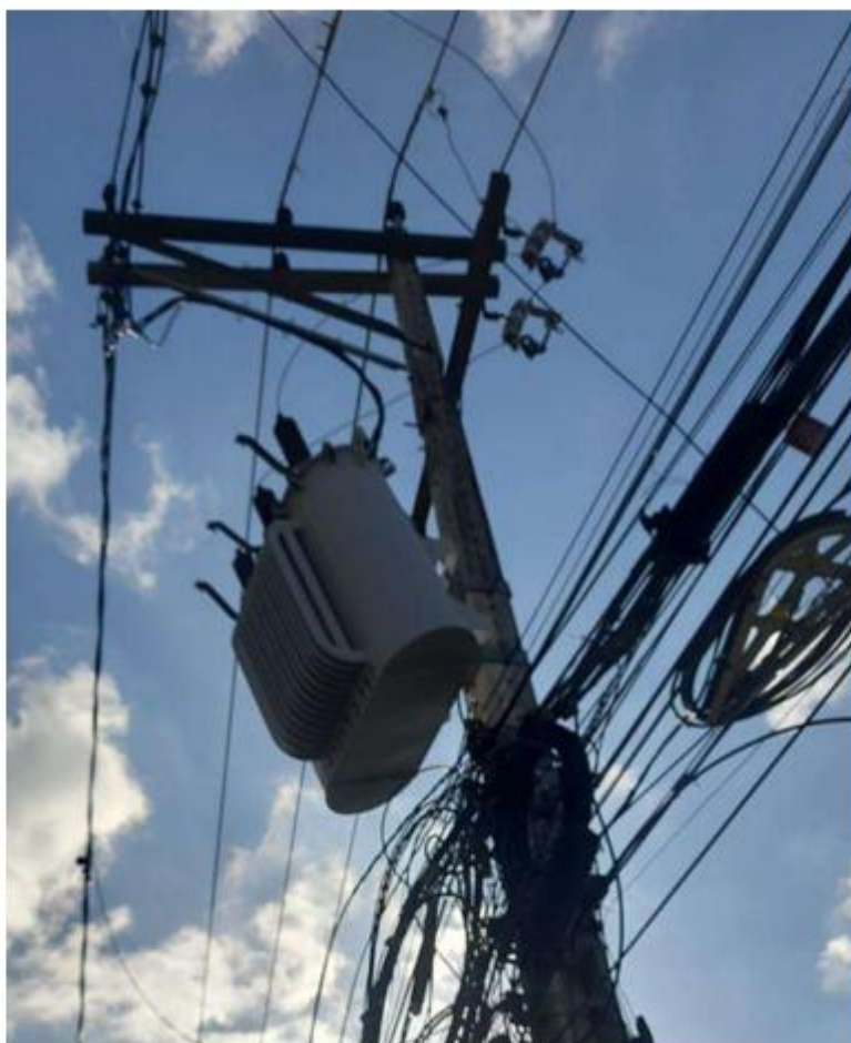
NECESSÁRIO SUBSTITUIR POSTE DE 11-400DT, COM ESTRUTURAS, 01-M2T, 01 N1CC - TRAFO DE 150kVA
