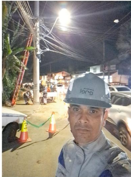
29/07/2025 – Equipe executando reparo na rede
