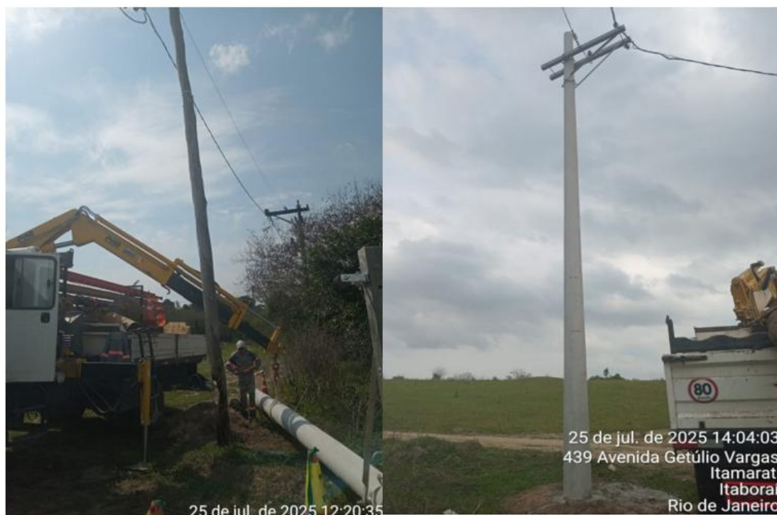
1 POSTE DE MADEIRA 11MTS - SUSTENTA UMA M2T COM CABO 4 NA MT E ENCABEÇAMENTO PRÉ REUNIDO CABO 50 - PRÓXIMO AO PONTO S315628
