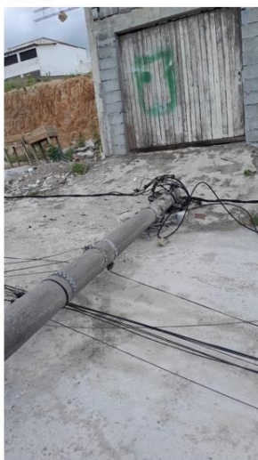
10/04/25 Poste quebrado Trafo F632808
