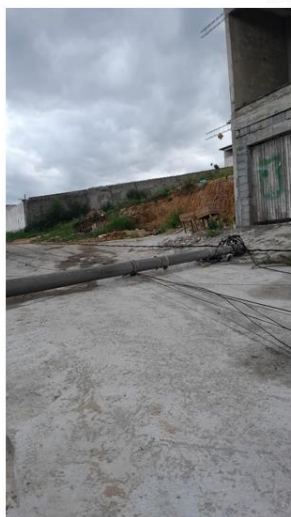
10/04/25 Poste quebrado Trafo F632808
