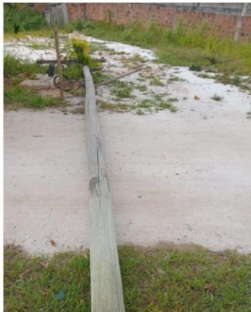
Necessário substituir 1 poste de 11M quebrado com estrutura N2 completa , 30 mts de cabo 2 AL
