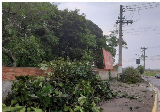
Registro Polo Niterói – Informar Localidade: INO01 Data: 06/10/2023
