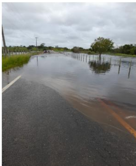
Dia 01/12/2022 Incidência 18771733 – Descargas atmosféricas
