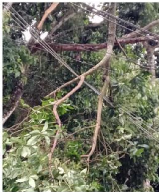
Registro Polo Macaé – Queda de galho de grande porte 29/07
