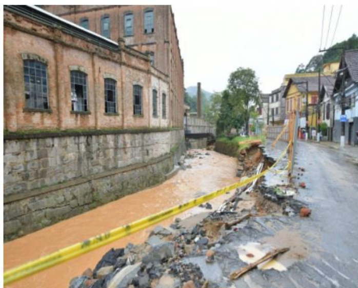
Secretaria de Infraestrutura e Obras vai realizar as intervenções na Rua Quissamã, uma das áreas mais atingidas pelas chuvas de domingo (20/03) / Foto: reprodução
