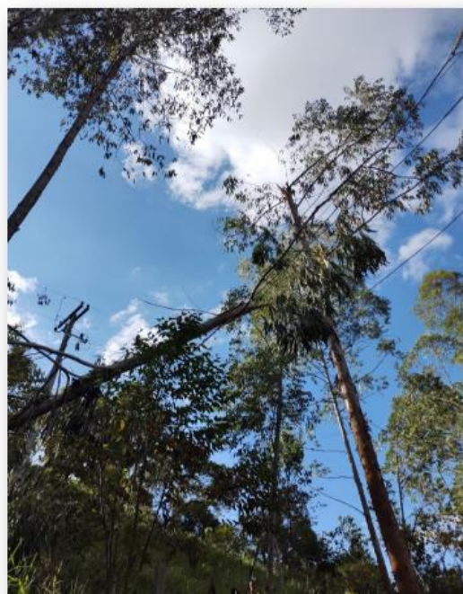
Registro Polo Macaé – Queda de árvore 21/03
