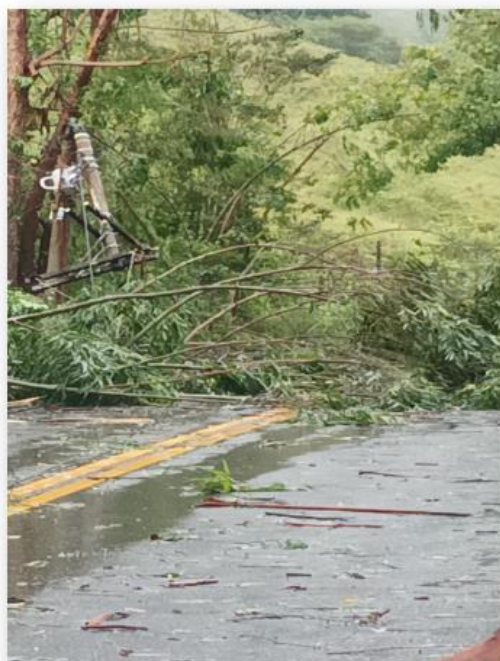
Registro Polo Macaé – Queda de árvore 21/03
