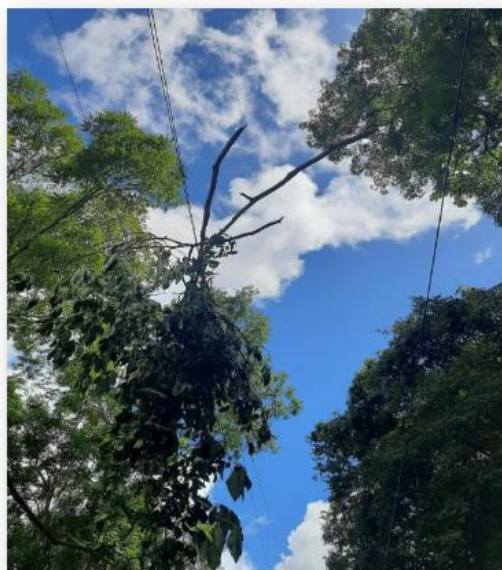
Registro Polo Macaé – Queda de árvore 20/03
