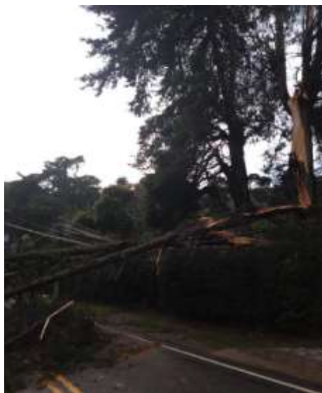
Quedas de árvores RDC02 Estrada Bernardo Coutinho – Araras Petrópolis
