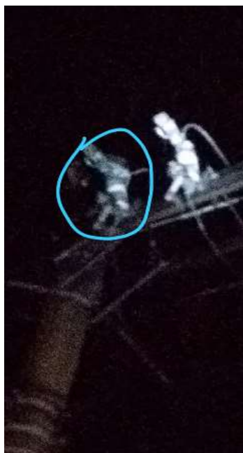
Descarga Atmosférica Cabo Partido TE62906 Teresópolis
