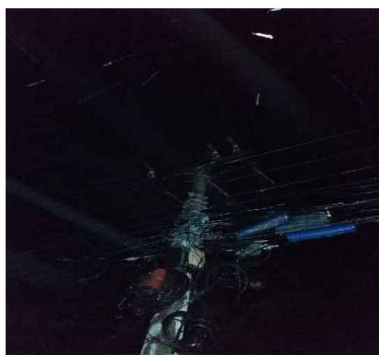
Descarga Atmosférica TE62906 Teresópolis
