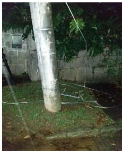
Descarga Atmosférica Cabo Partido TE60270 Teresópolis
