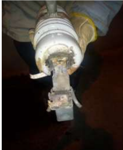
Desarme Alimentador BGN01 Descarga Atmosférica Condutor Partido Petrópolis
