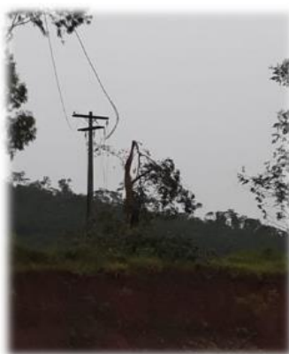
Condutor partido devido ao temporal – Alimentador ALC09.
