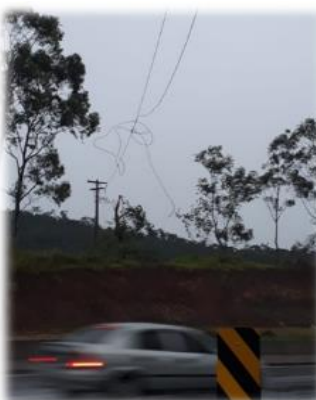
Condutor partido devido ao temporal – Alimentador ALC09.
