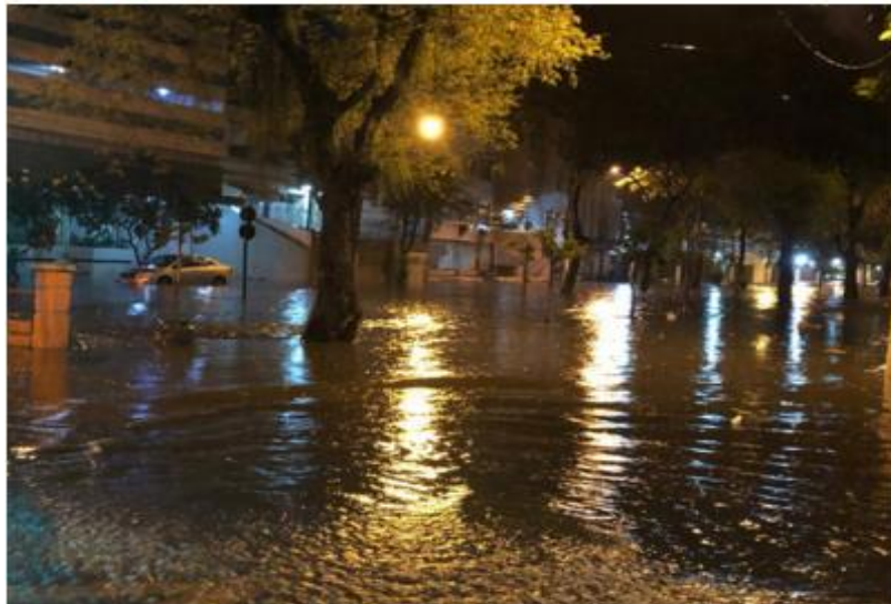
Canal da Avenida Almirante Ary Parreiras transbordou (Foto via Plantão Enfoco)
