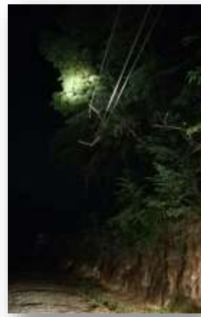
Queda de galhos sobre a rede
