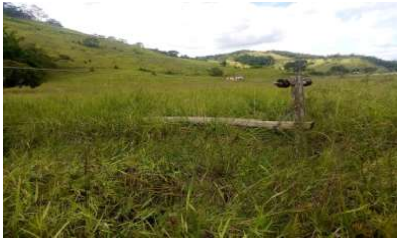
Poste "tombado" devido a "queda de arvore"
