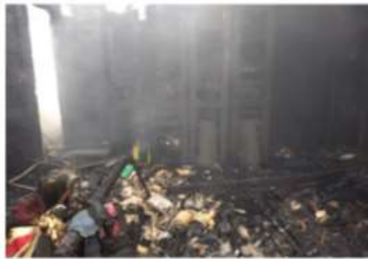
Restos de móveis e destruição de casa de madeira em Teresopolis, no RJ - Foto: 10/2018 Teresopolis/Divulgação
