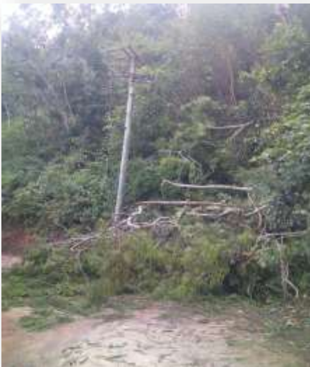
Queda de galhos de árvore
