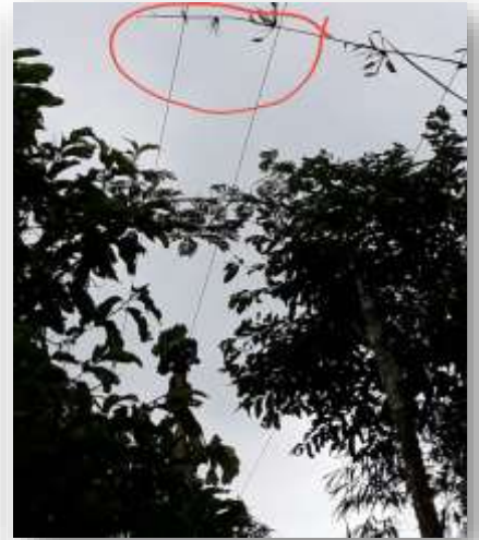
Queda de galhos sobre a rede
