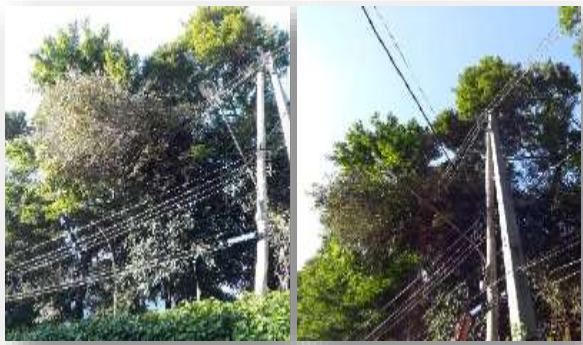
Queda de galhos na rede
