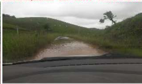
Estrada Adjacentes - SEM ACESSO - COM ENCHENTE
