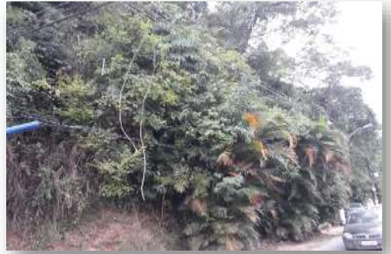
Queda de galhos na rede
