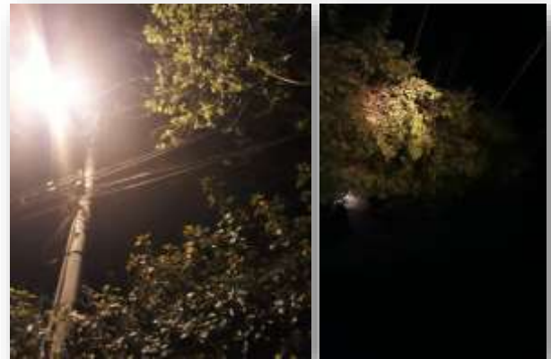
Queda de galhos na rede
