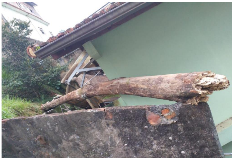
Desarme Alimentador ITA06 Queda de árvore Condutor Partido Petrópolis
