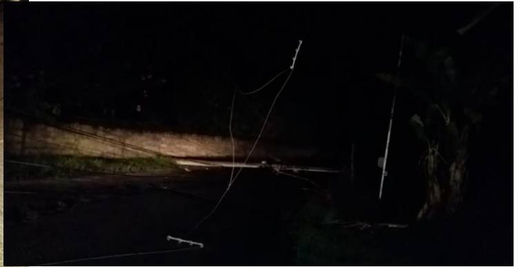
Poste tombado devido a solo encharcado
