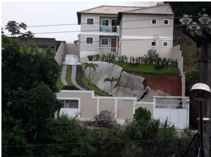
Muro de casa desaba após forte chuva no distrito de Bacaxá, em Saquarema, no RJ — Foto: Gustavo Fagundes Barbosa/arquivo pessoal
