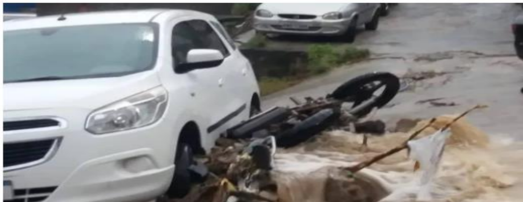
No Bairro Sítio, em Arraial do Cabo, uma rua cedeu — Foto: Divulgação/Weling
