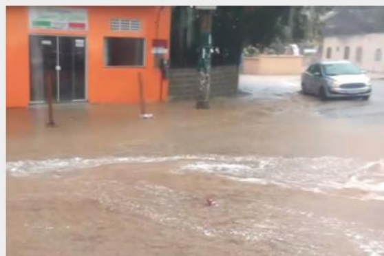
Ruas ficaram completamente alagadas em Arraial do Cabo (Foto: Ouvinte BandNews FM)
