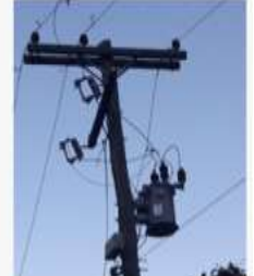
BJD03 – Substituído Poste, estruturas e 600mts cabo 4CAA e feito poda de grande porte,
