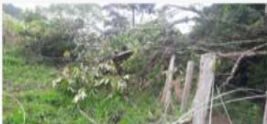
TAP02 – Feito poda de grande porte, substituído lance de MT e cadeia de isoladores.
