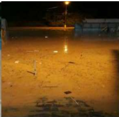
RDC01 - Pátio da empreiteira e canteiro de Obra dia 03/03
