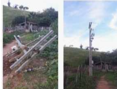
VPA02 – Substituído Poste, estruturas, Transformador e 100mts de cabo 4CAA
