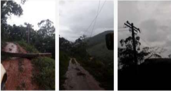
TRM01 – Substituído 150mts de cabo 4CAA, feito poda.
