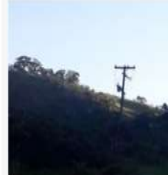
BJD03 – Substituído Poste, estruturas e 600mts cabo 4CAA e feito poda de grande porte,
