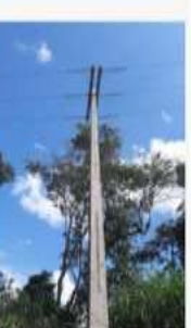
BJD03 – Substituído Poste, estruturas e 600mts cabo 4CAA e feito poda de grande porte,
