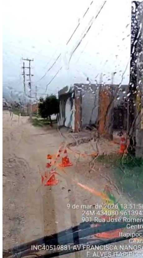
Figura 7. Foto registrada no dia 09/03/26 às 13:51 na localidade Itapipoca.
