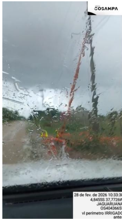
Figura 8. Foto registrada no dia 28/02/26 às 10:33 na localidade Jaguaruana
