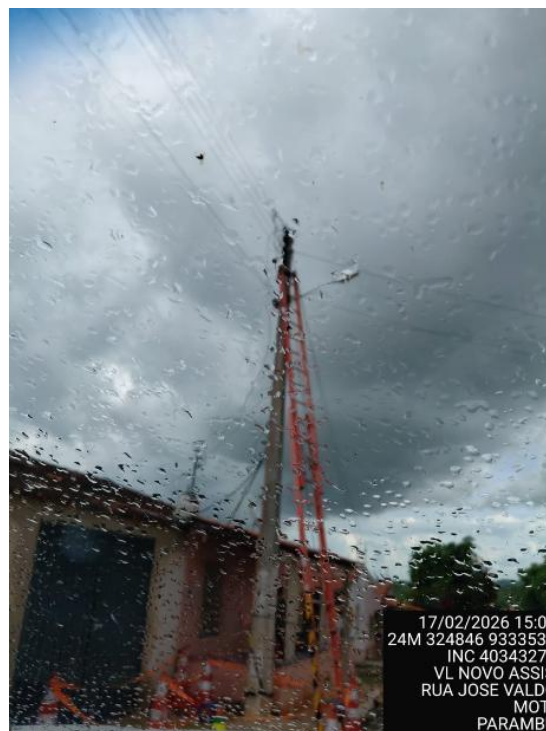
Figura 10. Foto registrada no dia 17/02/26 às 15:06 na localidade Parambu
