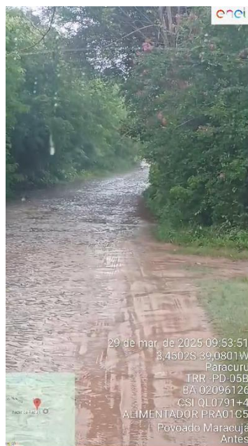
Figura 15. Foto registrada no dia 29/03/25 às 09:53 na localidade Paracuru.
