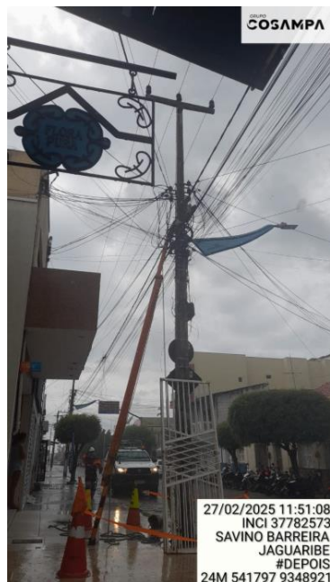
Figura 9. Foto registrada no dia 27/02/25 às 11:51 na localidade Jaguaribe.
