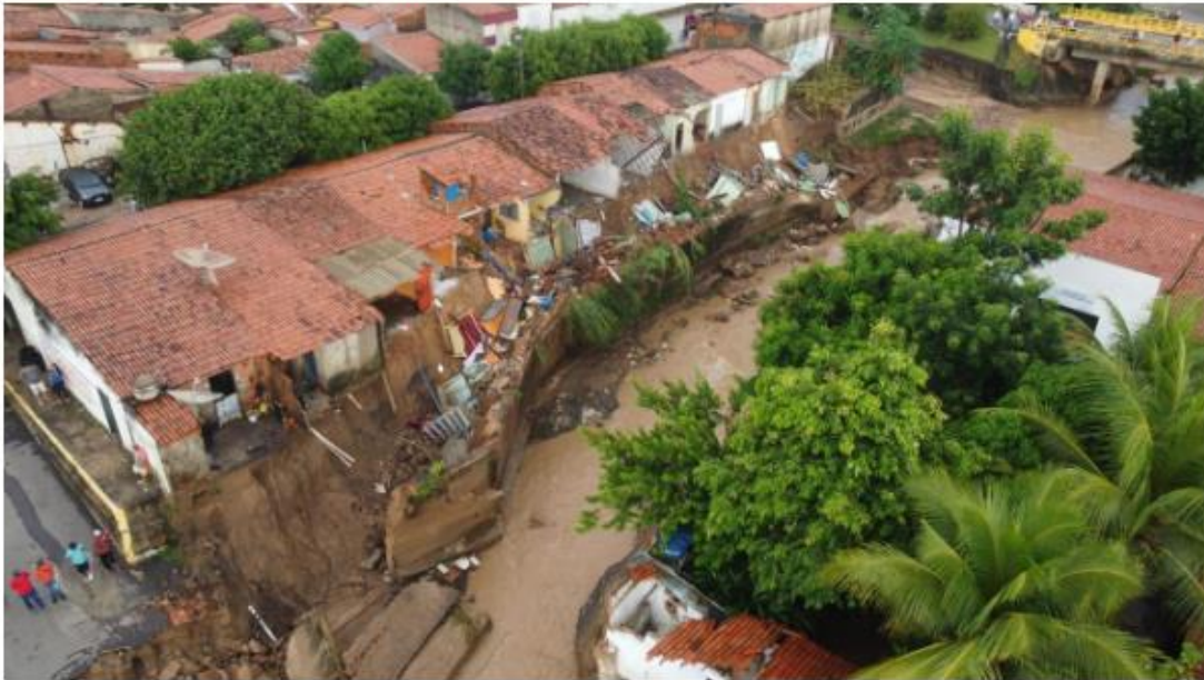
Legenda: Em Porielas, um paredão de sustentação rompeu e levou parte de casas Foto: Raony Pinheiro/Arquivo Passoaí
