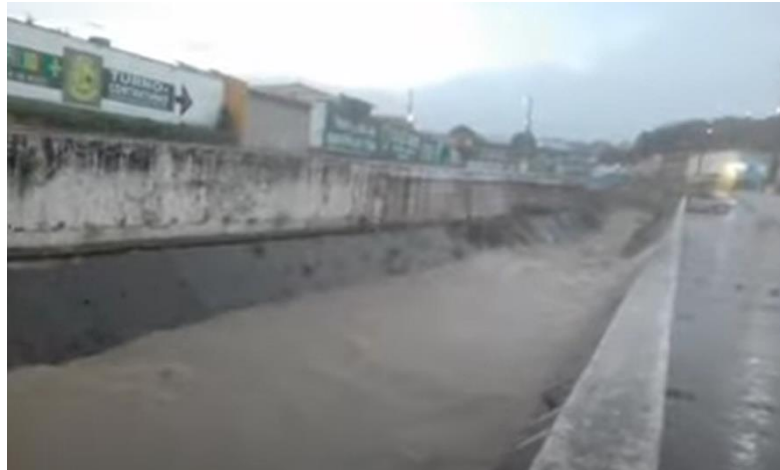
Figura 8. Foto registrada no dia 06/04/23 na localidade Crato.
