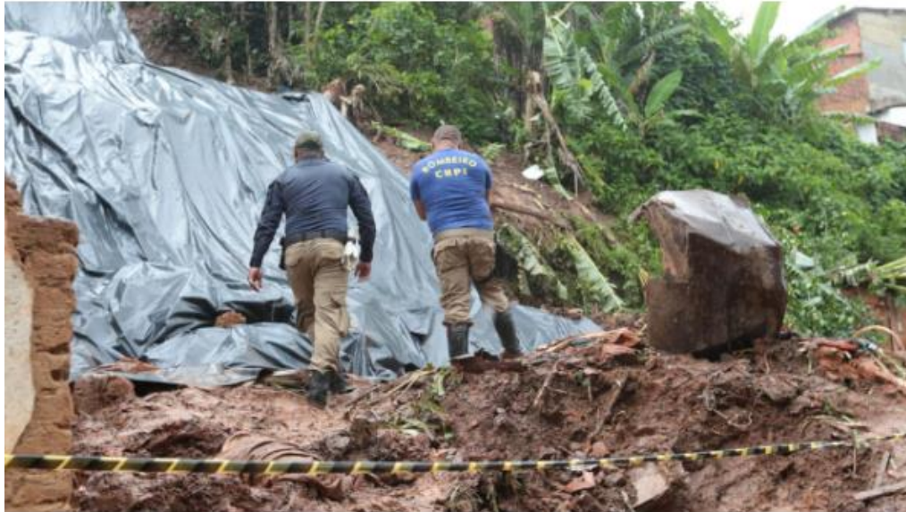
Legenda: Deslizamento em Astuba, no Ceará, deixou três mortos e se tornou símbolo trágico dos efeitos das chuvas no estado Foto: Fabiane de Paula
