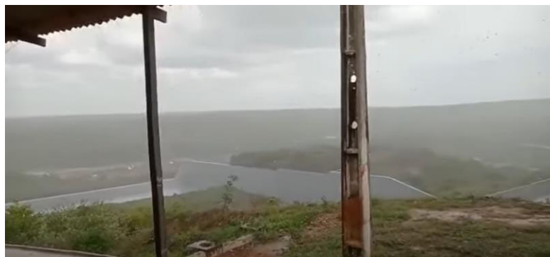
Figura 8. Foto registrada no dia 14/02/23 na localidade Banabuiú.
