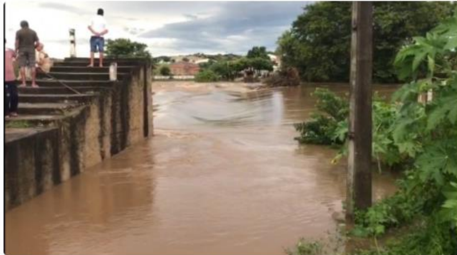
Em Lavras da Mangabeira, Rio Salgado está prestes a transbordar(foto: WhatsApp O POVO)
